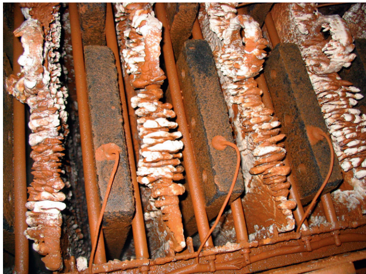
Рис. 11. Кассета к аппарату АЭ-А-80/120 с уловленными солями жесткости
